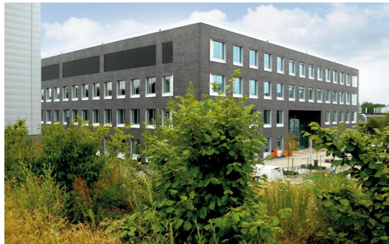
Bild 1: Der Forschungsneubau „Zentrum für Synthetische Mikrobiologie“ ist fast fertig, der Bezug soll im 1. Quartal 2020 beginnen. Zehn Forschungsabteilungen mit insgesamt rund 250 Mitarbeiterinnen und Mitarbeitern werden die modernen Labore und Büros beherbergen. Im Hintergrund rechts: Das Max-Planck-Institut für terrestrische Mikrobiologie. Im Zuge des Neubaus waren fünf Forschungsgroßgeräte beantragt worden. Alle Anträge wurden inzwischen bewilligt. (© J.-W. Kellmann)
